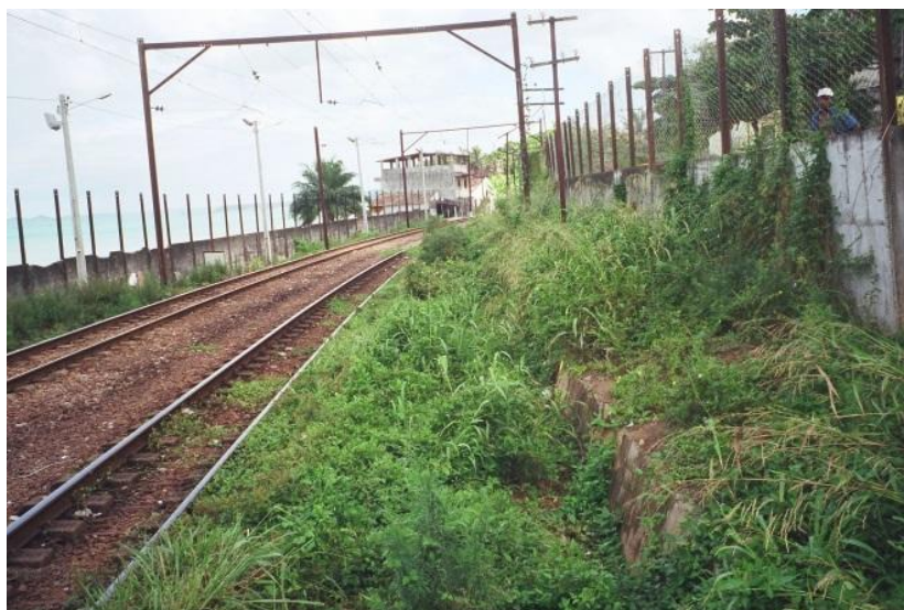
Figura 3.4 - Trecho Salvador/Paripe - Vista do muro de vedação
