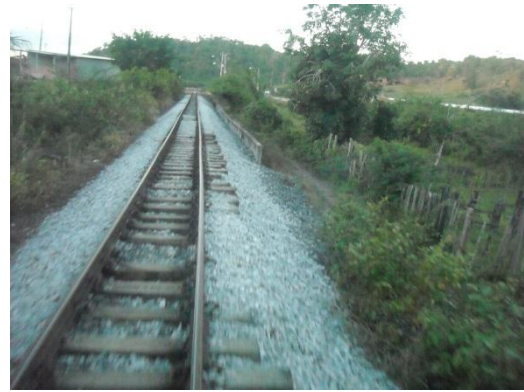
Foto 3.41 – Detalhe do lastro Ferrovia Centro Atlântico
