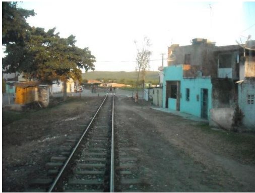
Figura 3.48 – Faixa de domínio invadida Ferrovia Centro Atlântico
