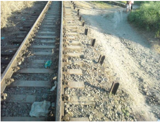
Foto 3.40 – Detalhe do trilho/dormente/fixação Ferrovia Centro Atlântico
