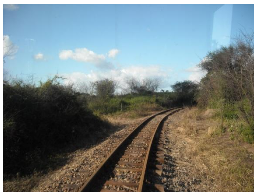
Figura 3.36 – Ausência de demarcação da faixa Ferrovia Centro Atlântico
