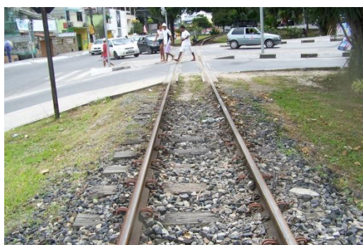
Figura 3.27 – Passagem Camaçari Ferrovia Centro Atlântica
