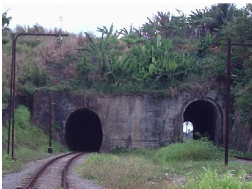
Figura 3.9 – Trecho Paripe/Mapele Túneis de Periperi
