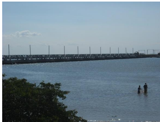
Figura 3.10 – Trecho Paripe/Mapele Ponte São João
