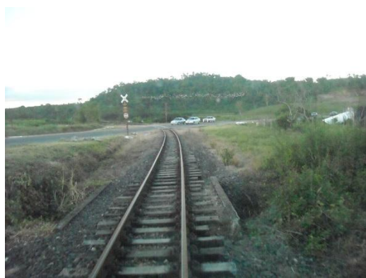
Figura 3.46 – Passagem em nível com rodovia Ferrovia Centro Atlântica
