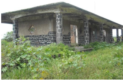
Figura 3.21 – Estação de Mapele Propriedade do DNIT
