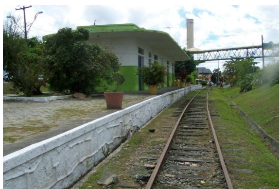
Figura 3.20 - Estação de Camaçari Ferrovia Centro Atlântica
