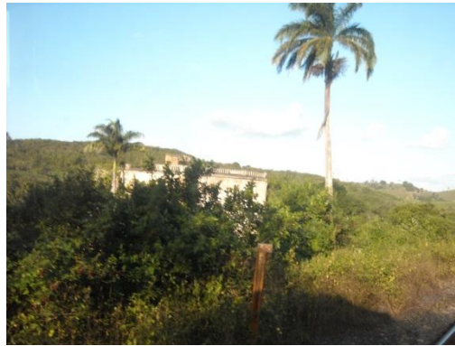
Figura 3.49 – Faixa de domínio preservada Ferrovia Centro Atlântico
